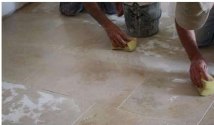
Рис.3 Заполненные цементом поры травертина
